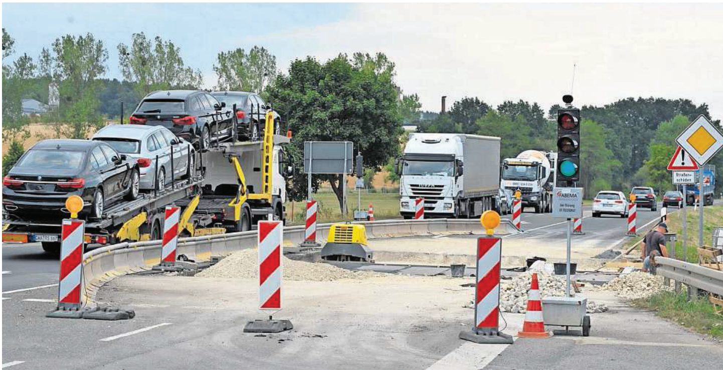
Neue Asphaltdecke für die B4: Verkehrsteilnehmer müssen sich in den kommenden Wochen auf Einschränkungen einstellen. Damit die Sanierung am 20. August starten kann, sind die Arbeiten zur Optimierung der Radweg-Unterführung bei Großheirath (Foto) bereits in vollem Gange. Foto: Christoph Scheppe
