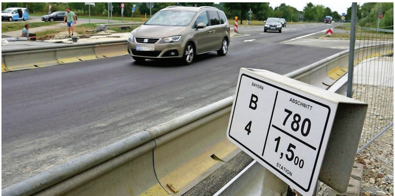
Vorbote: Wenn die Arbeiten an der Unterführung des Geh- und Radweges bei Großheirath abgeschlossen sind, geht es auf der Bundesstraße 4 im südlichen Landkreis Coburg erst richtig los. Dann wird auf rund acht Kilometern Länge die Fahrbahn zwischen Untersiemau und Kaltenbrunn erneuert. Foto: Berthold Köhler
