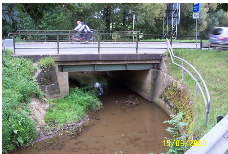
Best. Straßenbrücke über den Brandbach
